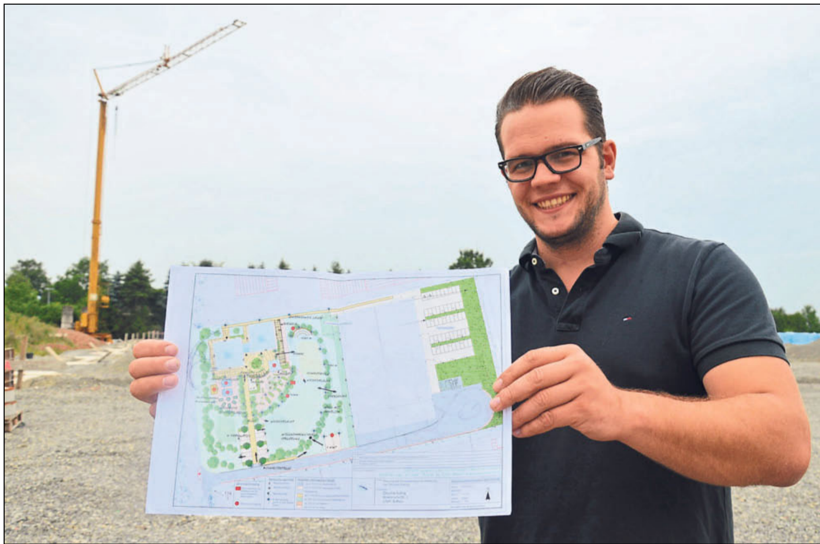
Der Schotter für die mehr als 3000 Quadratmeter große Halle ist verteilt, die Fundamente gegossen. Zwischen Boffzen und Höxter errichtet die Ölmühle Solling einen neuen Firmensitz. Geschäftsführer Sebastian Baensch (29) hat die Pläne vorgestellt. Foto: Marius Thöne
